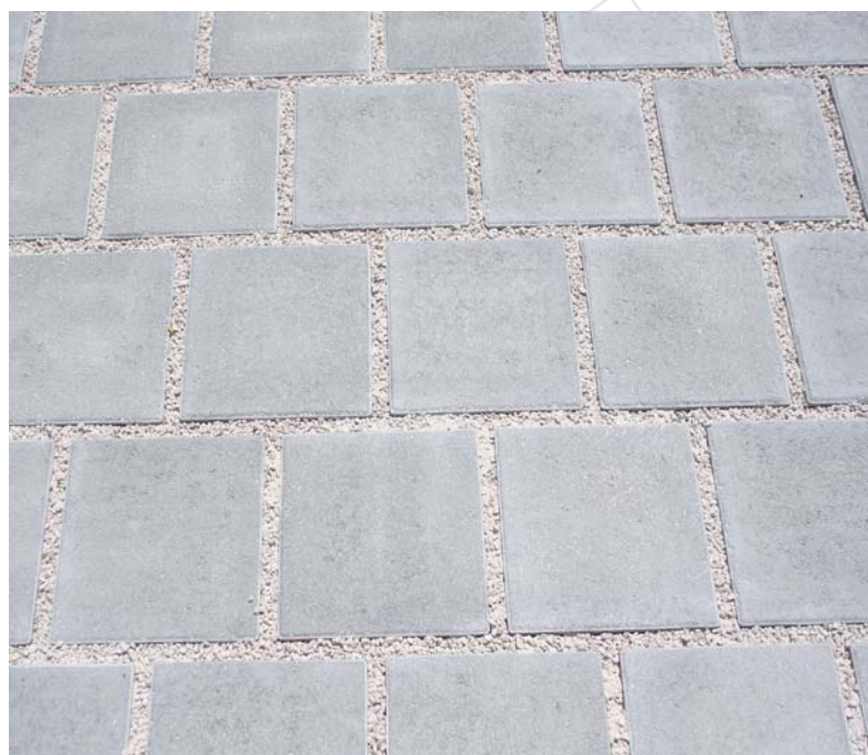
Pavés drainants Carus - pose à joints croisés
