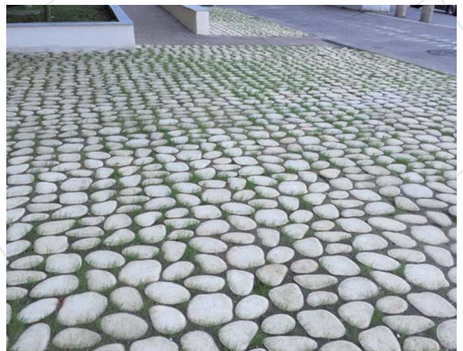
Dalles drainantes Durance végétalisées COMMUNIQUÉ DE PRESSE - SEPTEMBRE 2023
